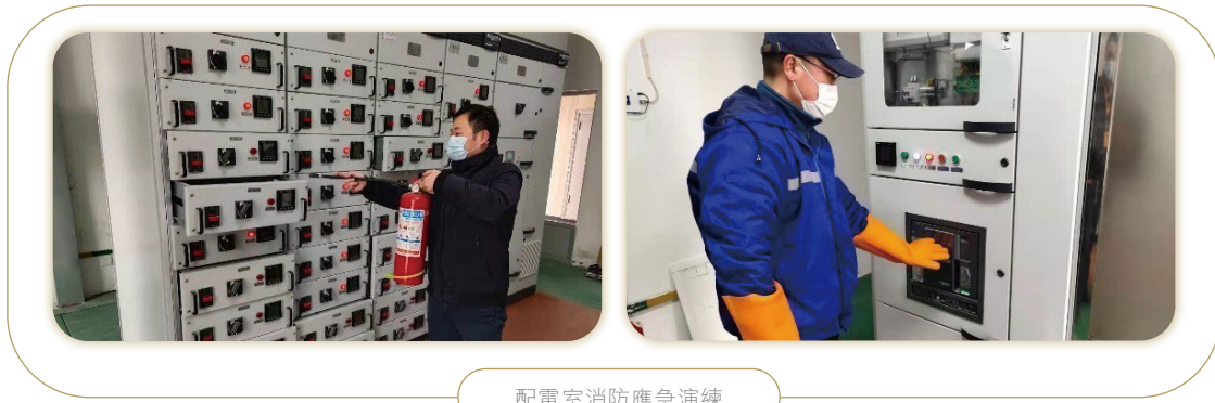
配電室消防應急演練
